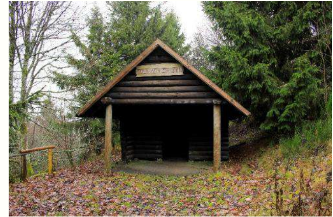
Schutzhütte Heidkopf, Hallenberg
