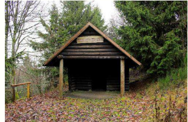
Schutzhütte Heidkopf, Hallenberg
