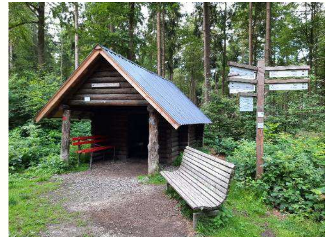
Schutzhütte Millionenbank, Bad Berleburg
