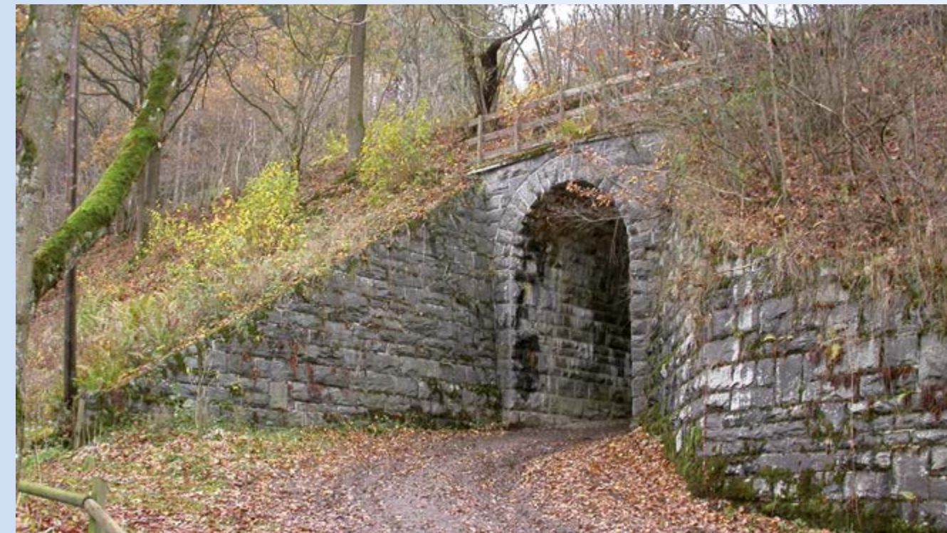
Bahnunterführung der ehem. Bahnstrecke aus Bruchsteinen
