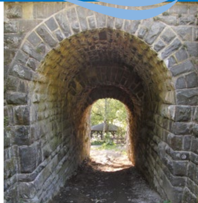
Bahnunterführung der ehemaligen Bahnstrecke aus Bruchsteinen
