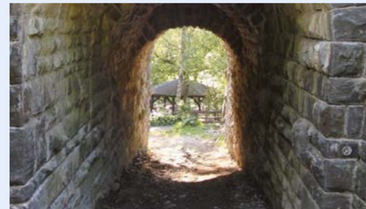
Bahnunterführung mit Blick auf den Brunnen
